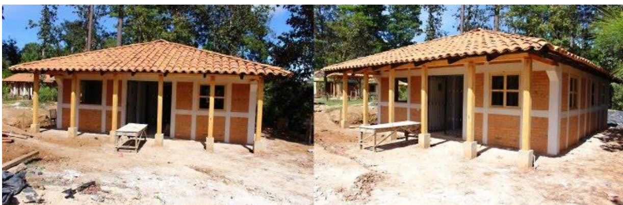
Construction du laboratoire de plantes médicinales
