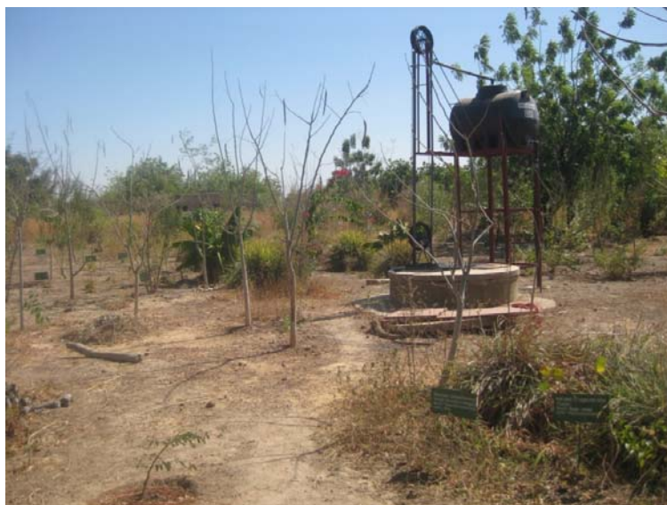
Jardin pédagogique de Kassou, en décembre 2013, un de nos puits, équipé d'une pompe manuelle et d'une réserve d'eau de mille litres
