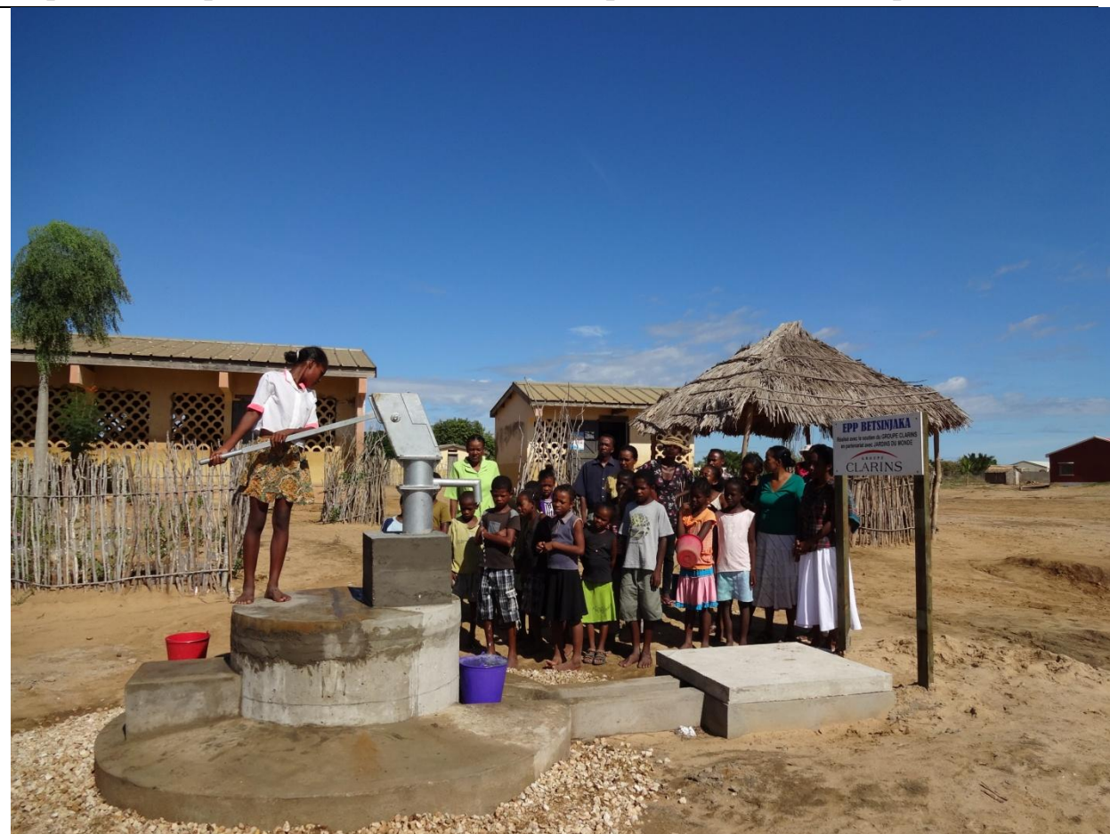
Mise en place d'un puits au Sud ouest de Madagascar.
